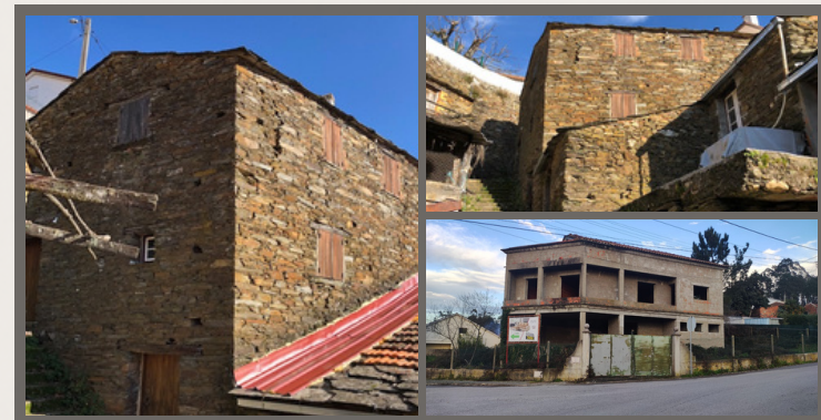
MORADIA DE 2 PISOS E LOTE DE TERRENO DE SEMEADURA COM CONSTRUÇÃO ARGANIL - CARANGUEJEIRA
